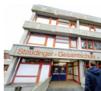
Sanierung lohnt nicht, sagt die Stadt zur Staudinger-Gesamtschule. FOTO: INGO SCHNEIDER
